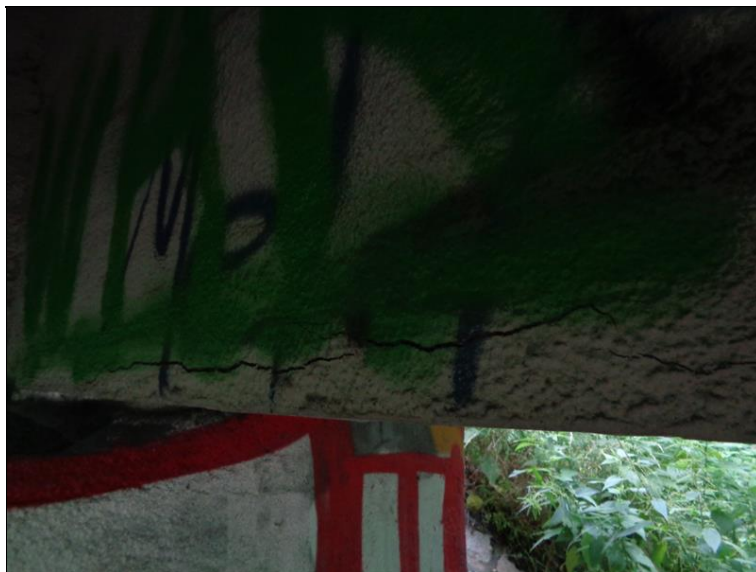
24 Trhliny v krajním tramu v poli 1 vlevo.JPG
