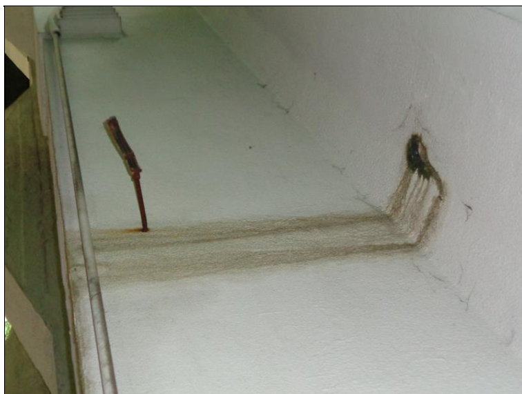
25 Chybející trubicka odvodnění v poli 1 vlevo.JPG
