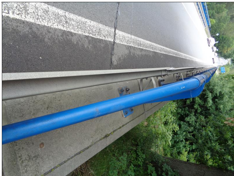
04 Leva krajnice rimsa a svodidlo.JPG
