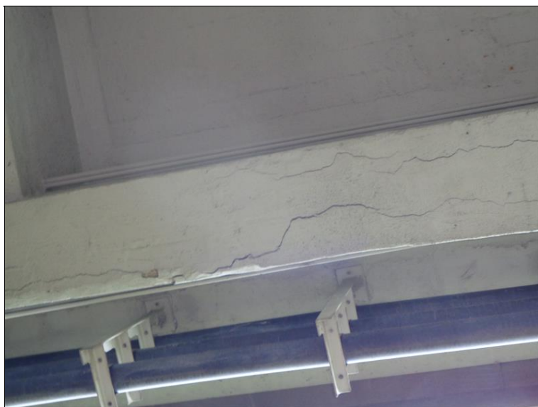
22 Trhliny v krajním trámu v poli 2 vpravo.JPG
