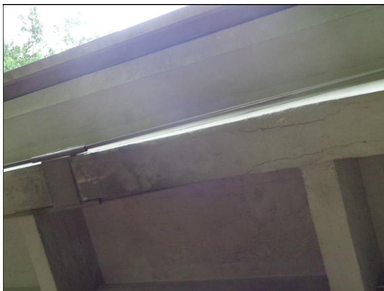
23 Trhliny v krajním trámu v poli 2 vlevo.JPG
